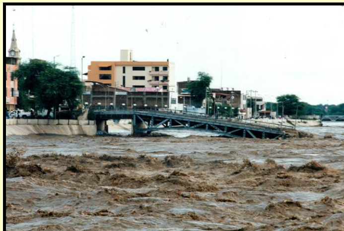
FIGURA N° 11 Colapso del Puente Viejo en 1998 (Fuente: UDEP)
