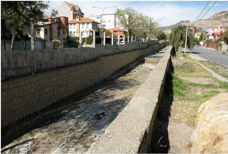
Fig. 4 El río canalizado Huayñajhuira river, en La Paz, Bolivia.
