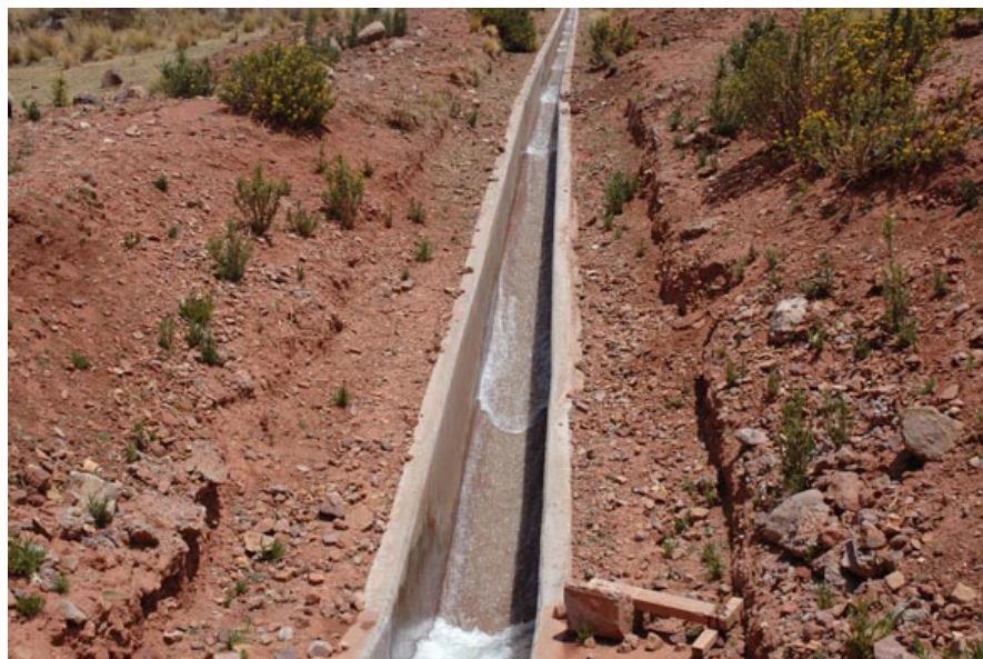
Fig. 2 Un evento de ondas de rollo en un canal lateral de la irrigación Cabana-Mañazo, Puno, Perú.
